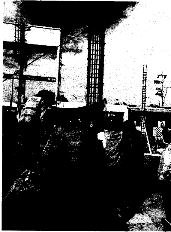
IZADO DE COLUMNAS EN SALA DE TAREAS PREVIAS
