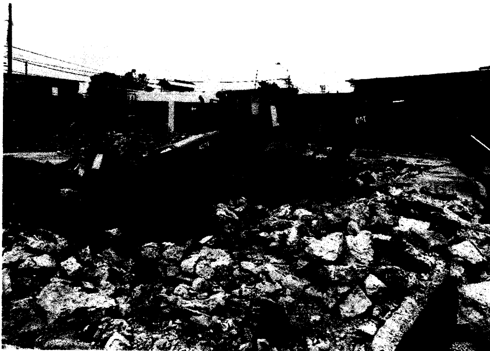
ELIMINACIÓN DE MATERIAL PRODUCTO DE LA DEMOLICION
